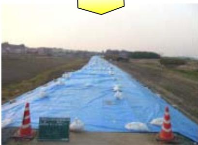
・堤防沈下・亀裂 L=420m
