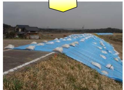
・堤防沈下・亀裂 L=108m
